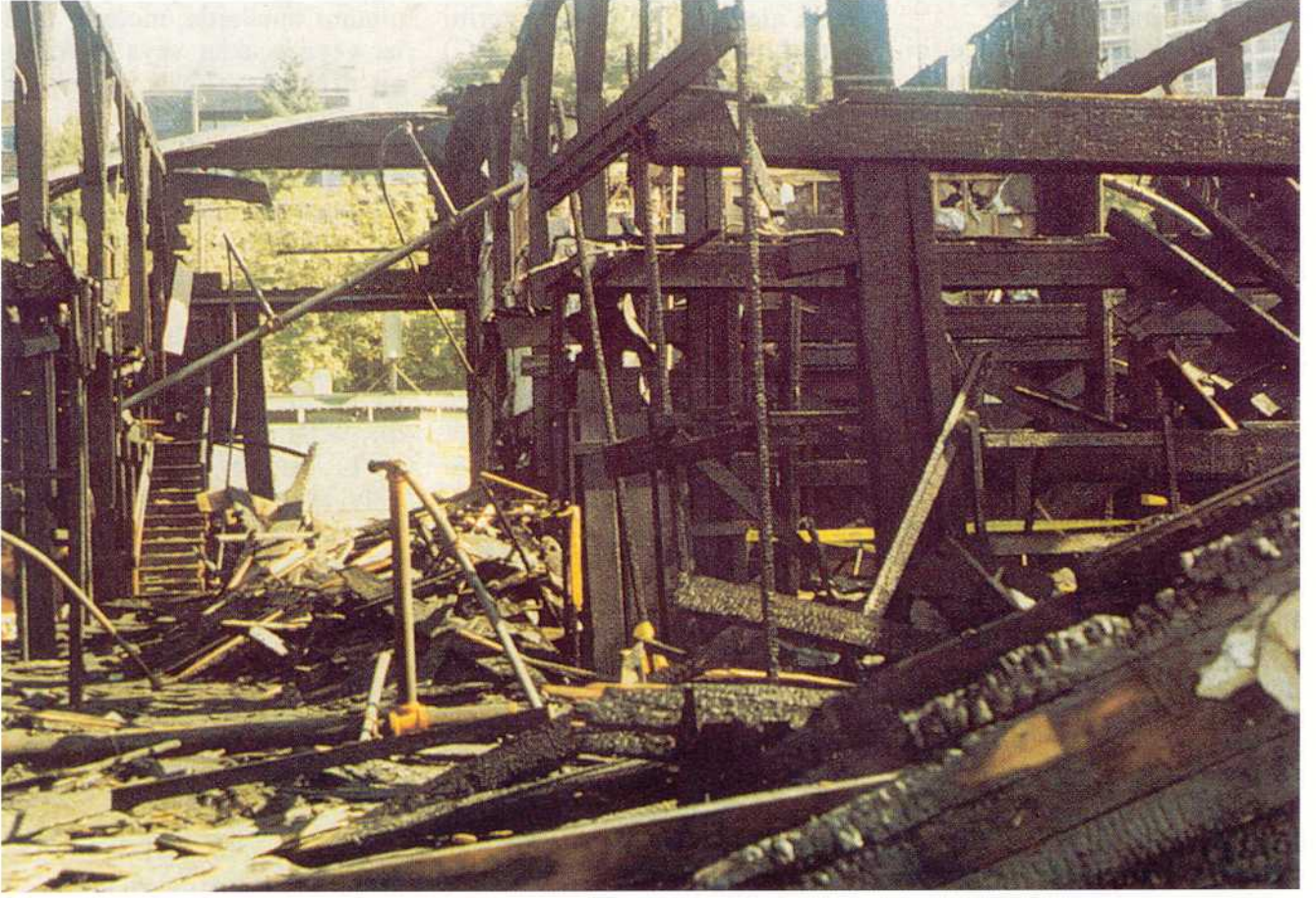
Aynı yangında, 1 saat süren aramadan sonra, resmin sağ alt köşesinde görülen 1 m. kadar yıkıntının altında, ölen yangıncının cesedi bulunmuştur.
